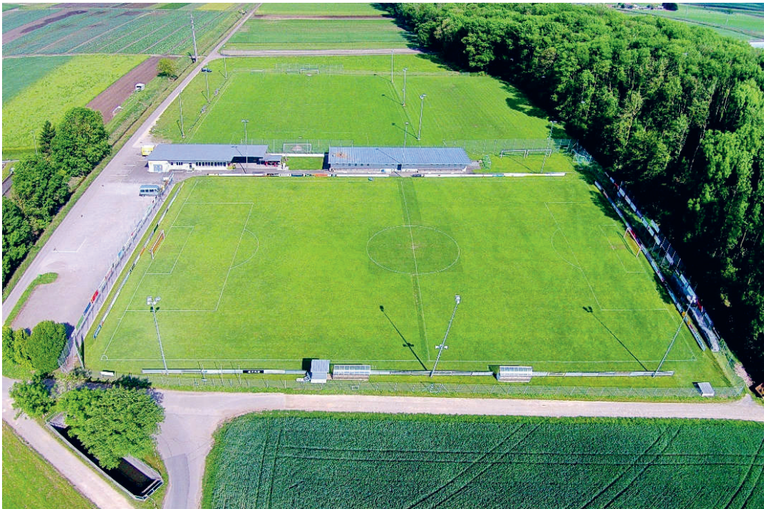
Bild: Fussballplatz Erli, im Vordergrund das zu sanierende Hauptfeld
